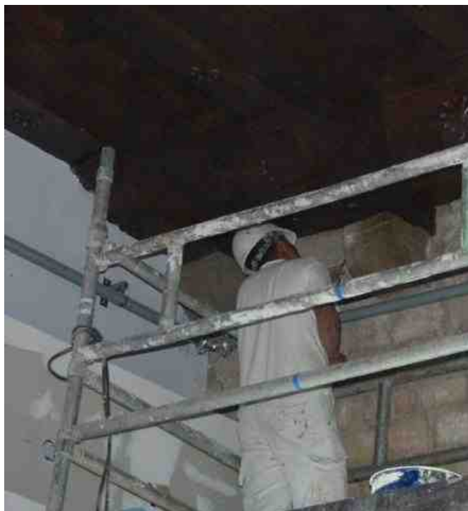
Imatge de la intervenció sobre els permòdols
