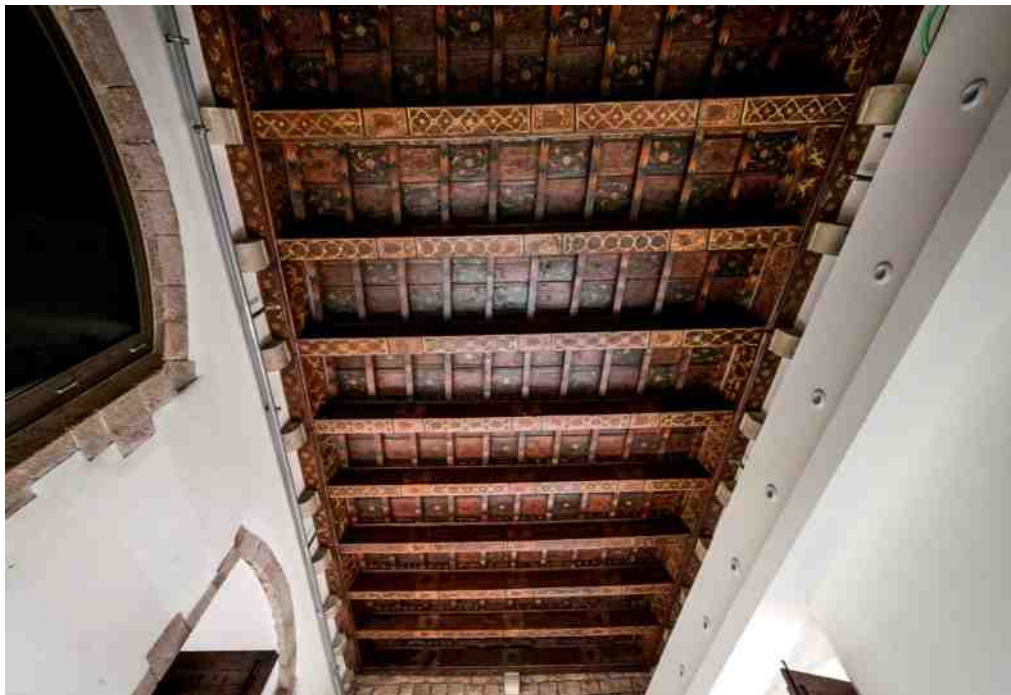
Fotografia general de l'embigat B, abans de la restauració
