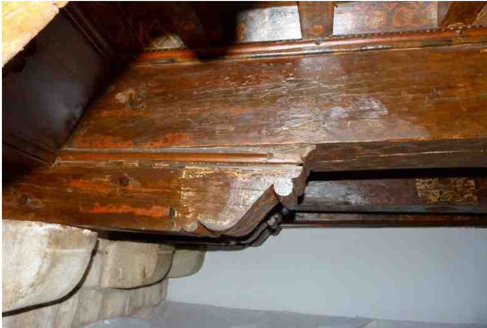
Fotografia on s'observa com les bigues es recolzen sobre les mènsoles i aquestes sobre els permòdols de l'embigat A.
