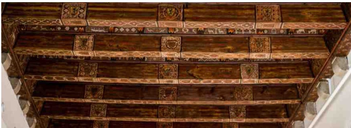
Fotografia on s'observa com les bigues recolzen directament sobre els permòdols (sense mènsules).
