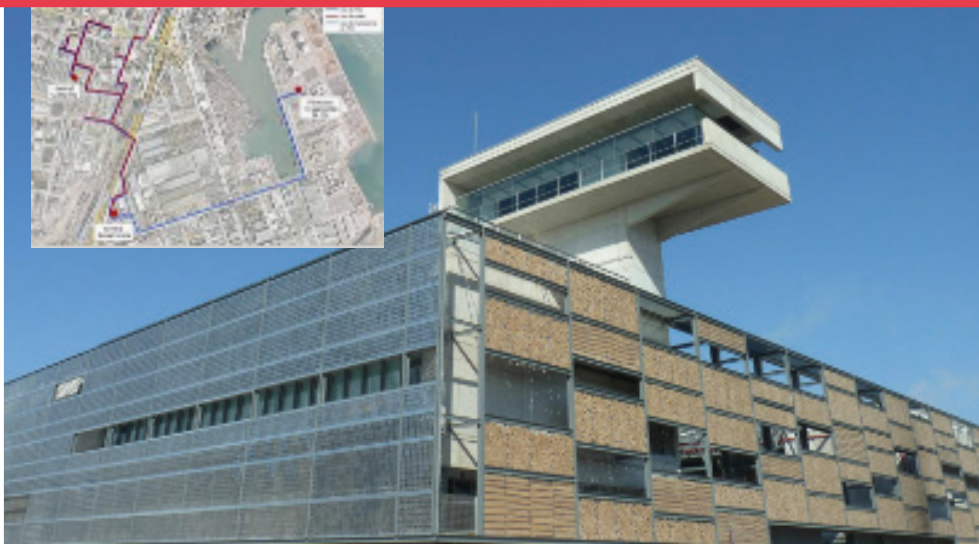
Imatge 15. Imatge de la central d'Ecoenergies i la xarxa de calor i fred a la Zona Franca.
